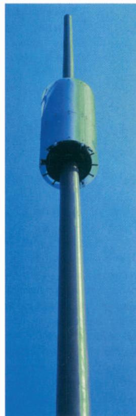
Roberto Pamio, "Torre-palo", Calzavara Telecommunication. Un cono rastremato di acciaio verniciato alto 32 metri (che regge anche i pali per l'illuminazione pubblica) è ancorato a terra da un plinto poligonale rivestito di ferro verniciato (diametro 90 cm) in cui si trovano le attrezzature tecniche. A 27 metri di altezza un cilindro apribile di policarbonato (diametro 140 cm, altezza 3 m) scherma le apparecchiature. La torre è installata in un quartiere residenziale di Treviso.
